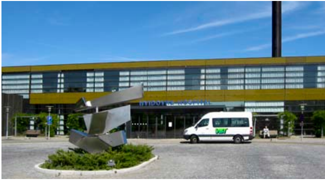
Hvidovre hospital, Hvidovre, Denmark
